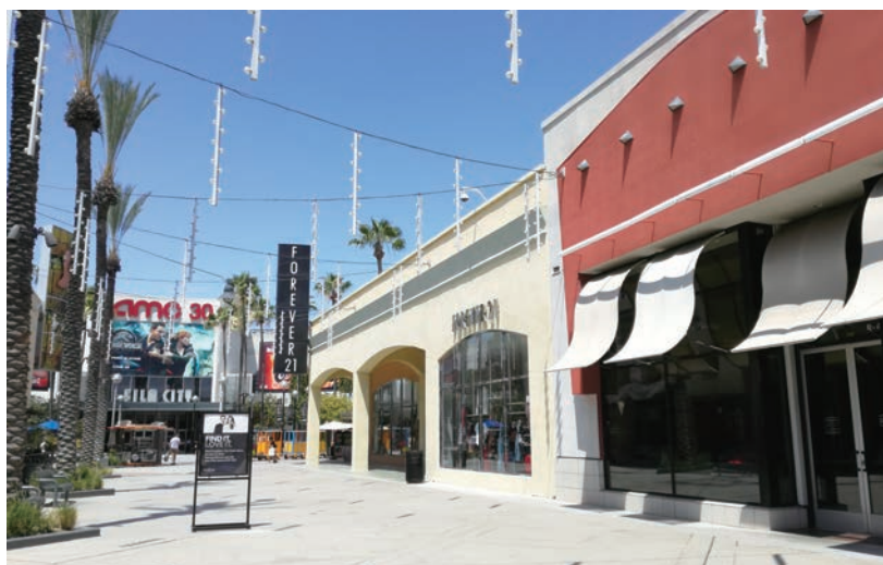
アウトレット商業施設
