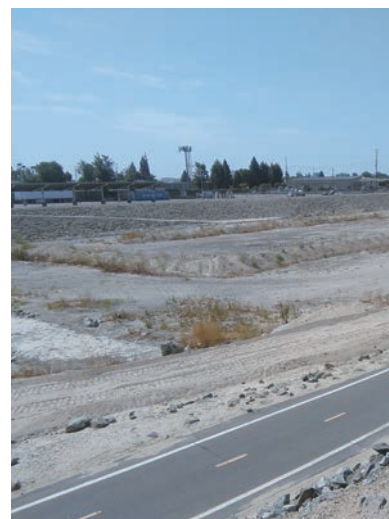
アナ川は工事のため、 枯れ川となっていた。
